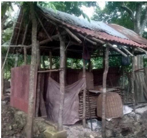
FIGURA 28. Estructura de la construcción del kumche' del campesino Decelio Salazar
